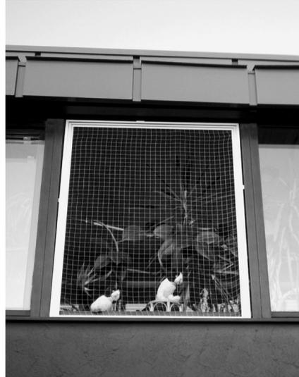
Katzenschutz-Rahmen mit **Netzfüllung** im Mittelfenster einer Balkoneinheit, eingepaßt und mit zwei Rahmen-Deckenspanner (Z9040) nach oben zur Decke ver-spannt.
