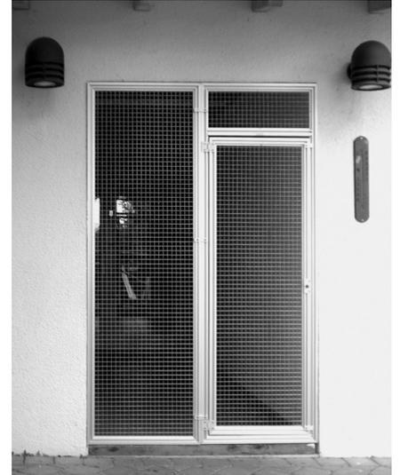
Sonderanfertigung einer Abtrennung vom Flur zum Aussenbereich mit Gitter oder Netzrahmen sowie einer Türe H: 1700 B: 600 mm, zur Decke „verspannt“ oder mit Winkel gedübelt.
