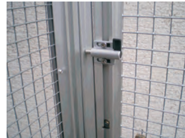
Arretierriegel Montage an der Türe hinter der Gitteröffnung schließend. Türe nach außen öffnend. Anschläge außen montiert
