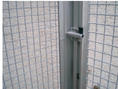
Arretierriegel Montage an der Türe, in der Systemnute schließend. Türe nach innen öffnend ! Anschläge innen montiert. Bild 10
