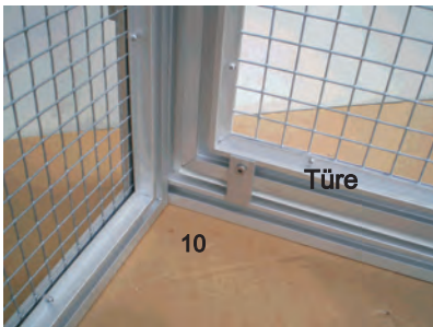
Türanschlag bei verdecktem Türrahmen !
