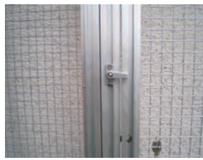
Riegel innen am Türrahmen montiert.
